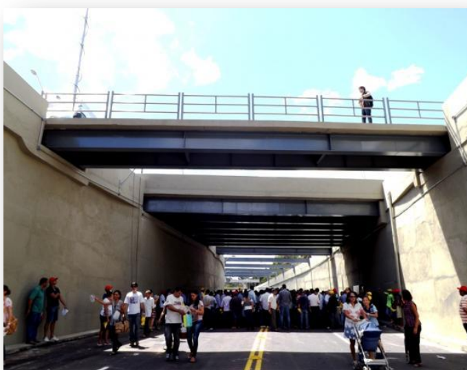
Figura 142 - Viaduto da Higino Cunha – Teresina Fonte: Secretaria de Infraestrutura do Piauí - SEINFRA, 2013
