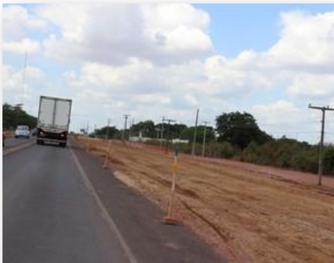
Figura 147 - Duplicação da BR 316 - Teresina – Demerval Lobão – Monsenhor Gil Fonte: Secretaria de Infraestrutura do Piauí - SEINFRA, 2013
