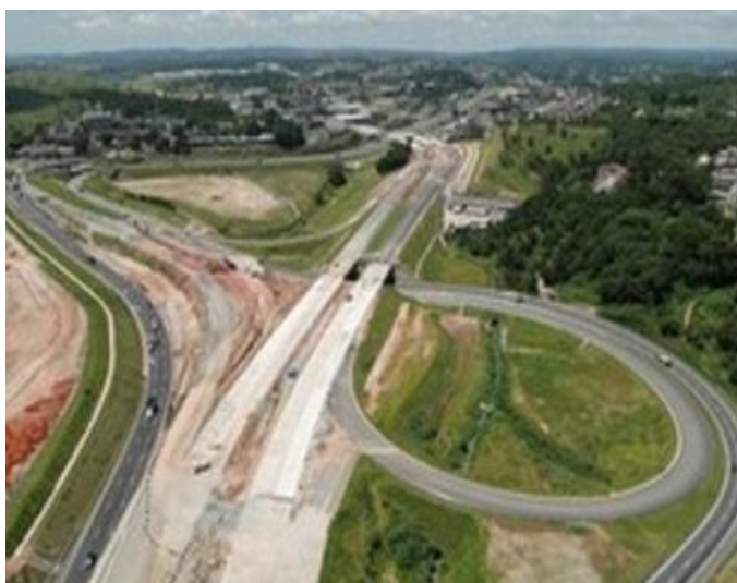
Figura 148 – Construção do Rodoanel do Município de União Fonte: Secretaria de Infraestrutura do Piauí - SEINFRA, 2013
