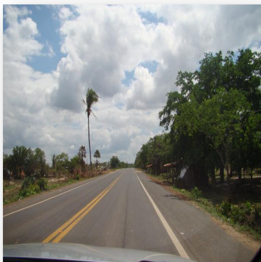
Figura 45 – Acesso ao Município
