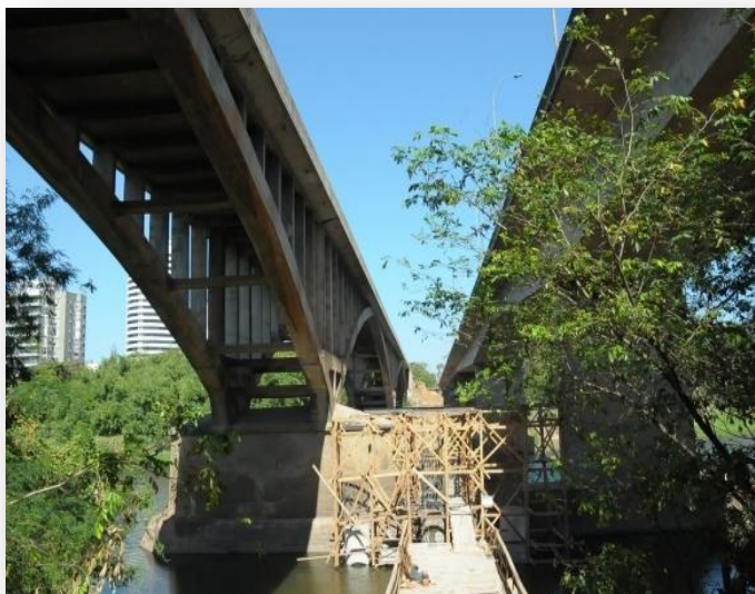
Figura 143 - Duplicação da Ponte Juscelino Kubstichek
