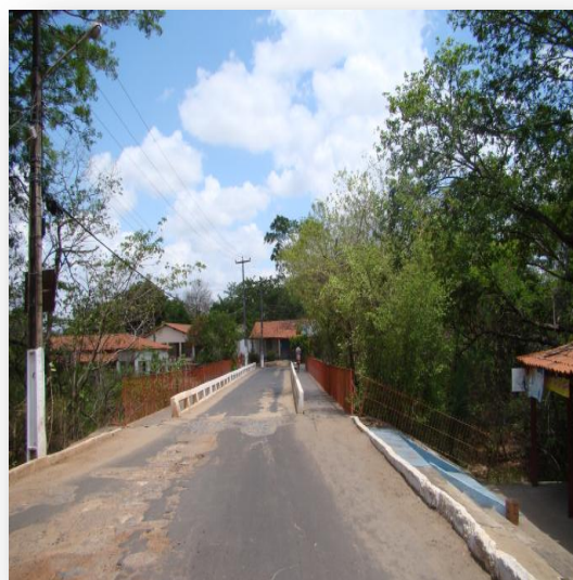
Figura 46 – Ponte sobre o Riacho Natal
