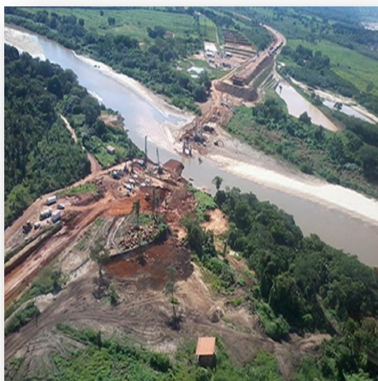
Figura 137 - Ponte em construção para ligação do Rodoanel 1
