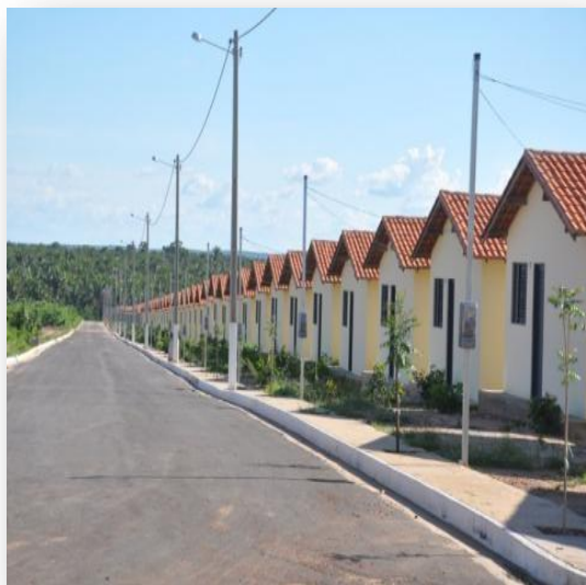
Figura 153 - Habitações concluídas no município de Timon (MA)
