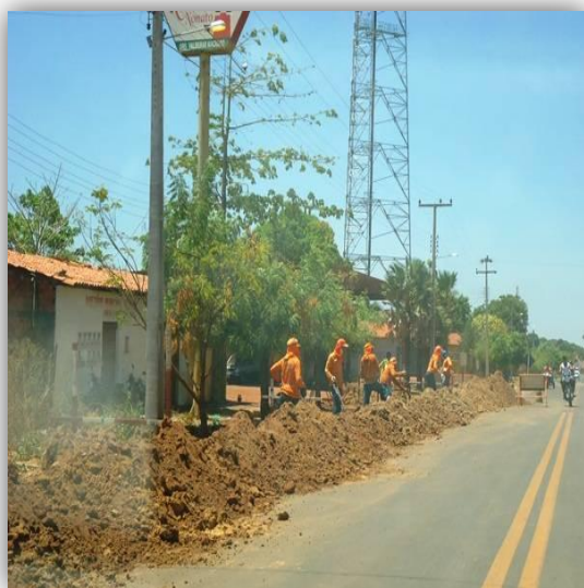
Figura 159 - Obra de Esgotamento Sanitário – União Fonte: Prefeitura Municipal de União, 2013
