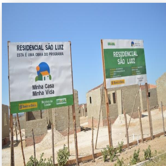
Figura 150 - Habitações em construção no município de Altos – Residencial São Luiz
