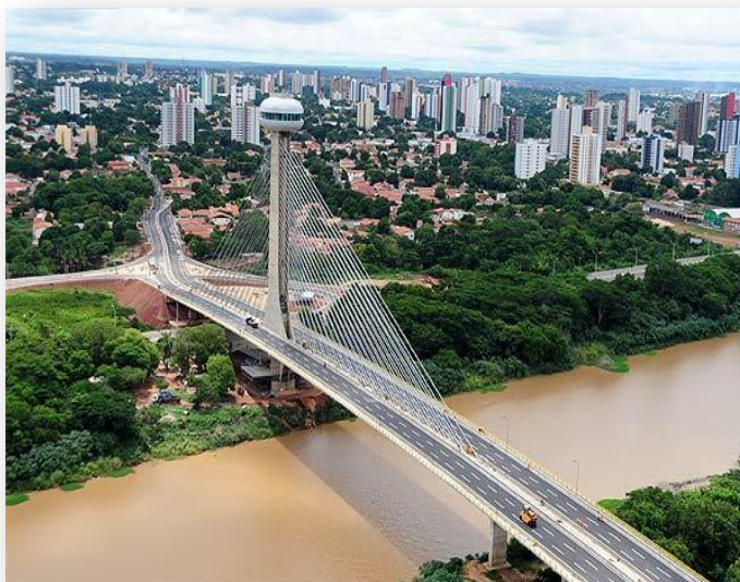
Figura 139 - Ponte Estaiada – Teresina
