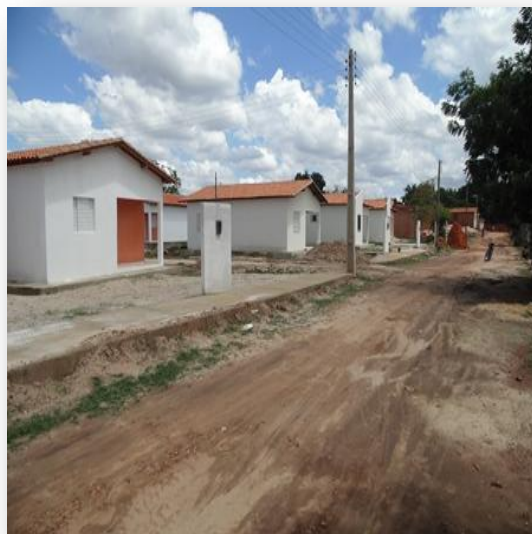
Figura 154 - Habitações em construção no município de União
