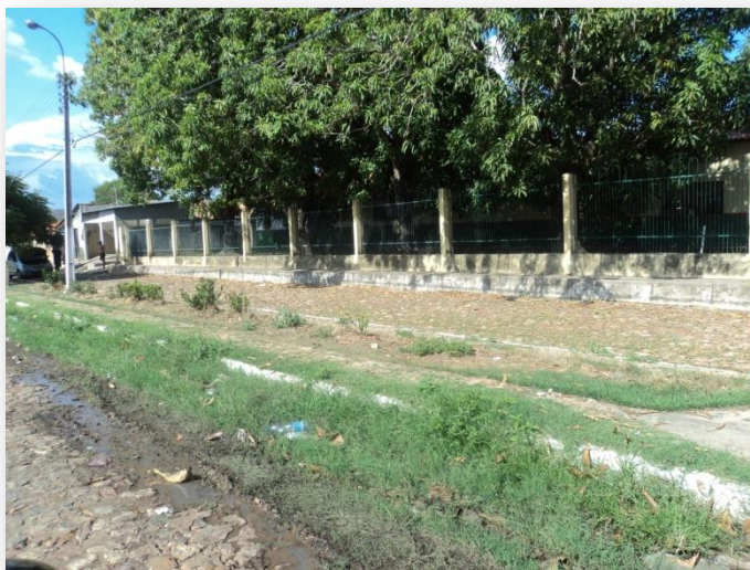
Figura 180 – Dejetos de esgoto a céu aberto no Município de Demerval Lobão Fonte: Empresa Expansão. Pesquisa Direta, 2013
