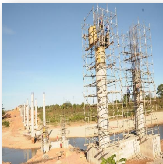
Figura 138 - Ponte em construção para ligação do Rodoanel 2
