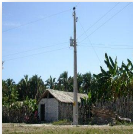
Figura 162 - Zona Rural de Altos Fonte: Eletrobrás Distribuição Piauí, 2013
