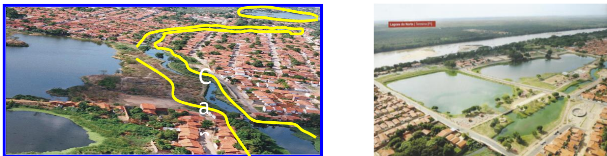
Figura 5 - IMAGENS DA SITUAÇÃO ANTES E DEPOIS DAS INTERVENÇÕES DO PLN I.
