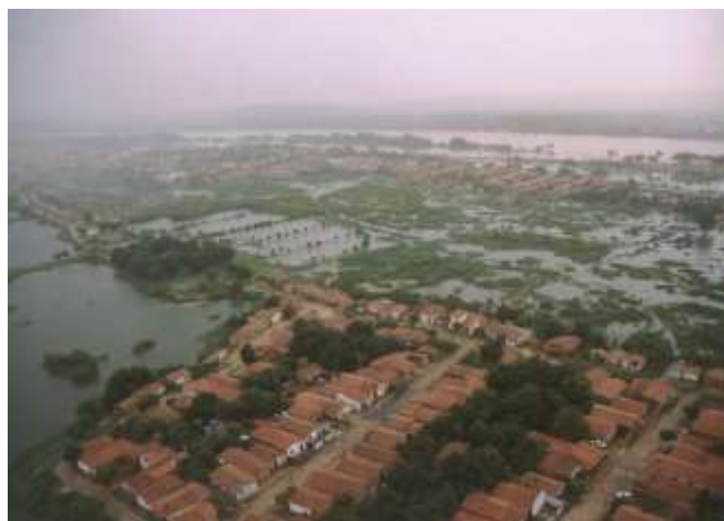
Figura 14 - IMAGEM DO EVENTO DE INUNDAÇÃO NA ÁREA DO PROGRAMA, OCORRIDO EM 1995.
