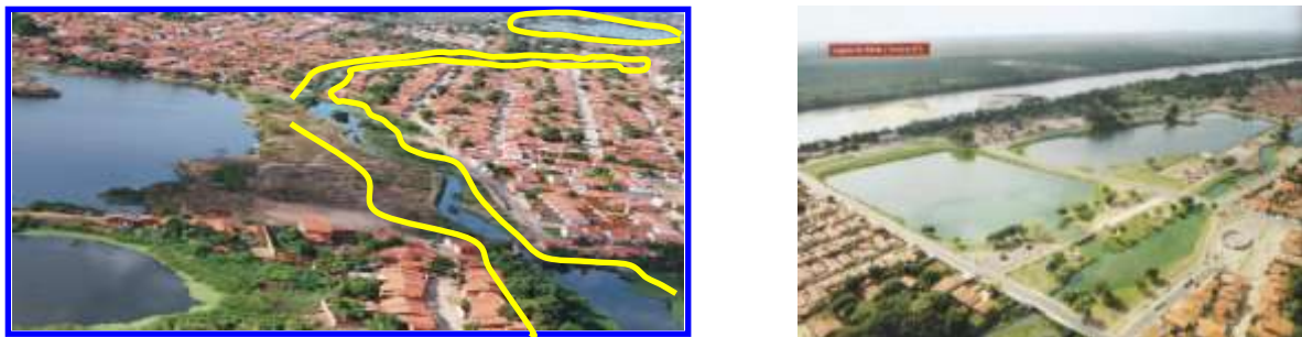
Figura 9 - IMAGENS DA SITUAÇÃO ANTES E DEPOIS DAS INTERVENÇÕES DO PLN I.
