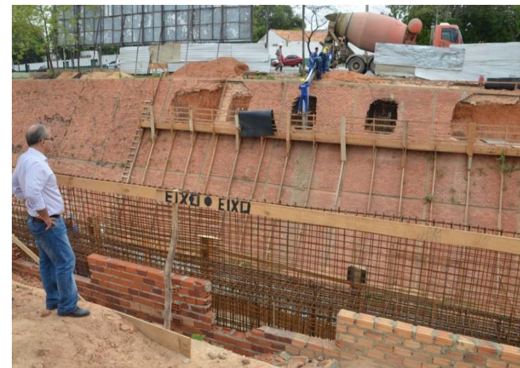
Viaduto na Miguel Rosa, ligando à Rua Juliano Moreira
