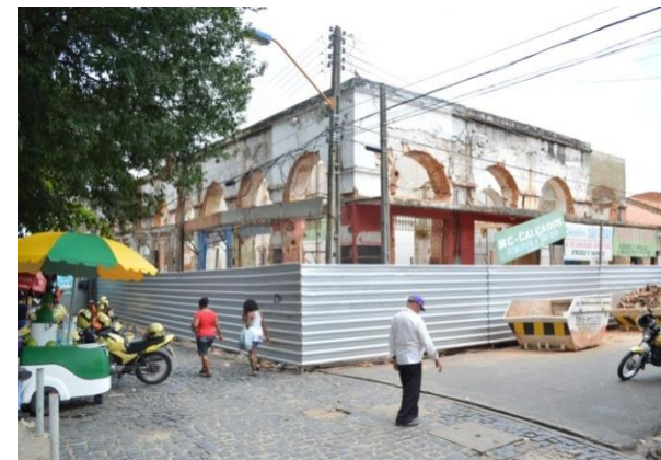
São José - Central (reforma)
