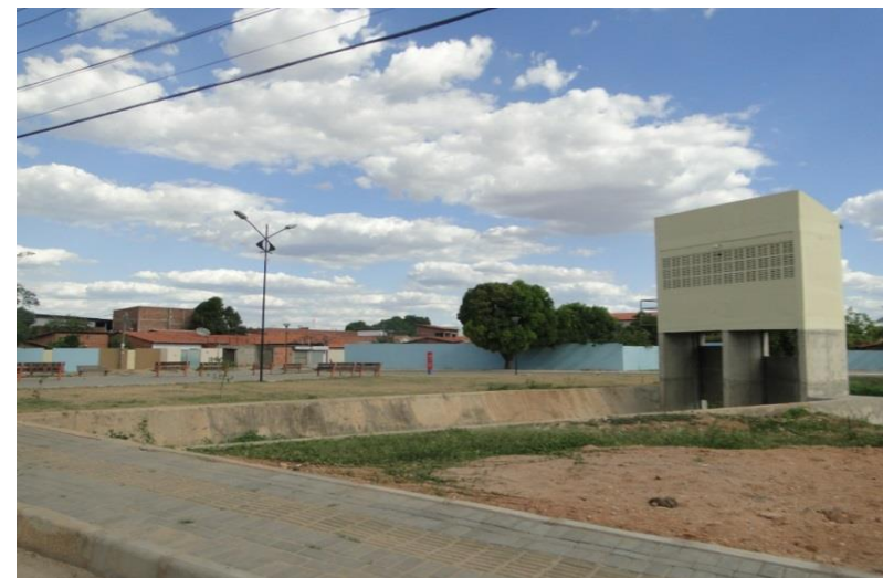
Obras de Macro drenagem
