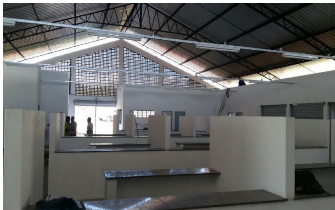
Vale do Gavião (construção)
