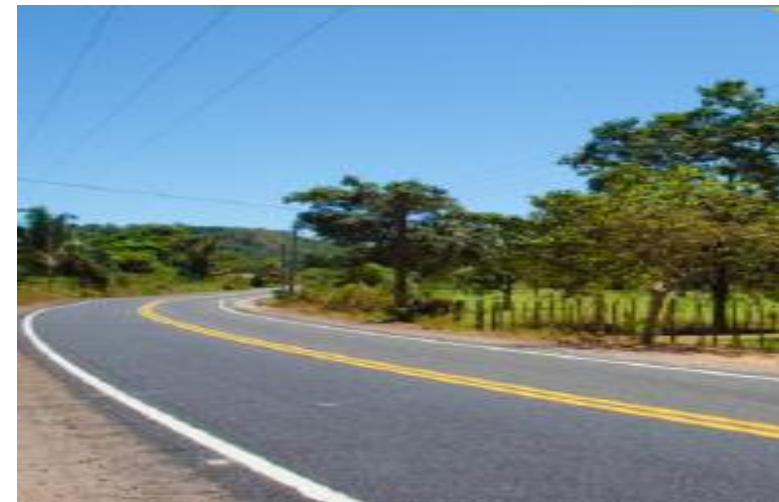
TER-345, trecho Santa Teresa – São João
