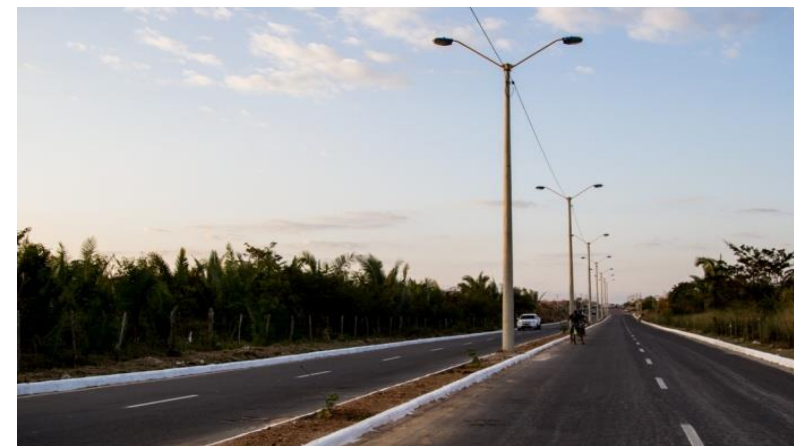
Construção da Via de ligação ao Residencial Paulo de Tarso.
