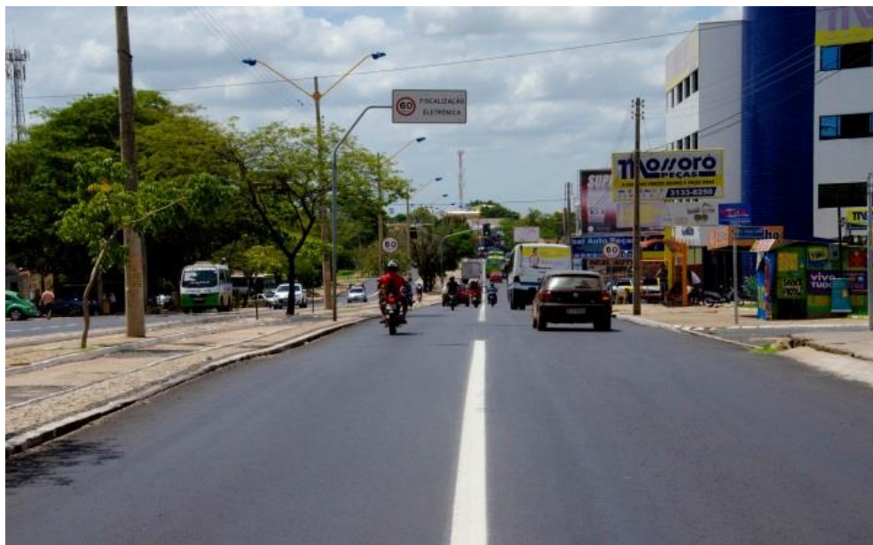
Recapeamento da Avenida Miguel Rosa
