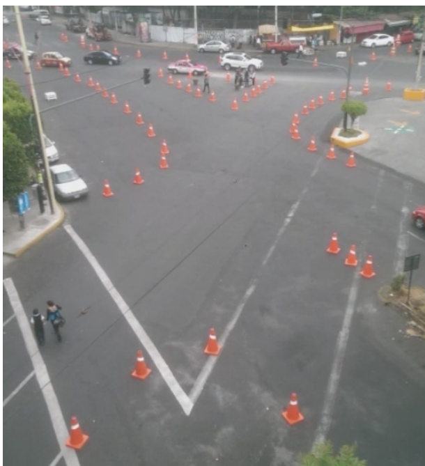
Foto 55: Exercício de readequação na geometria da interseção, em busca da segurança das pessoas que andam a pé, na Cidade do México – Intervención #Camina: Más espacio para el peatón 3 Fonte: Peatónito, 2015. Disponível em: https://vine.co/v/OYau6THiXKO
