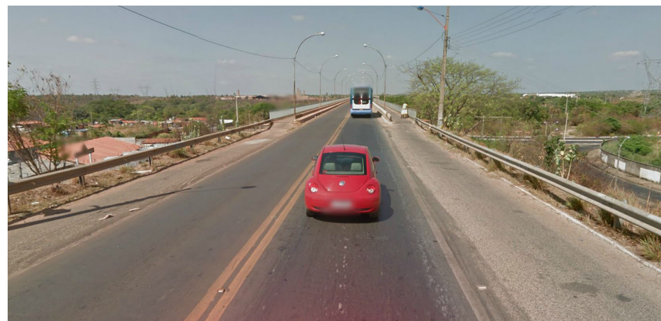
Foto 20: Ponte Nova, próximo à divisa de estados, no lado do Piauí Fonte: Google Maps, 2012
