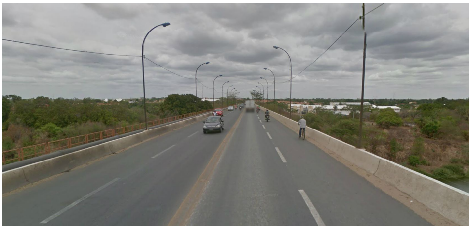
Foto 21: Ponte do Tancredo Neves, sentido Sul-Sudeste Fonte: Google Maps, 2012
