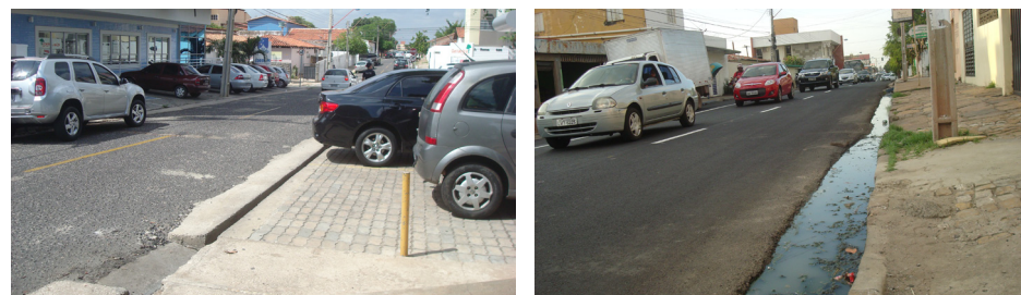
Foto 7: Descontinuidade da sarjeta, para acesso de veículos aos lotes e água acumulada Fonte: TC Urbes, 2014
