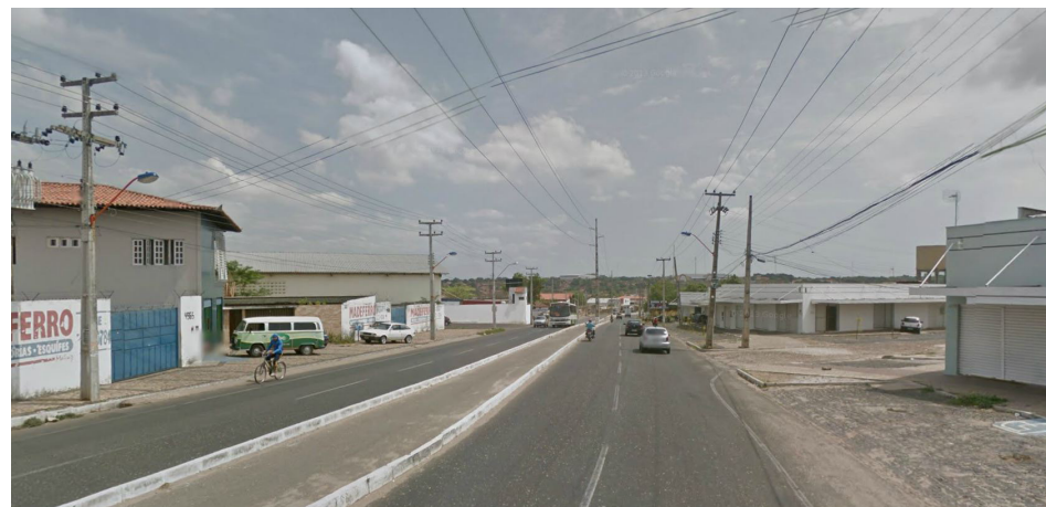
Foto 43: Ciclovia da Av. Maria Antonieta Burlamaqui Fonte: Google Maps, 2012
