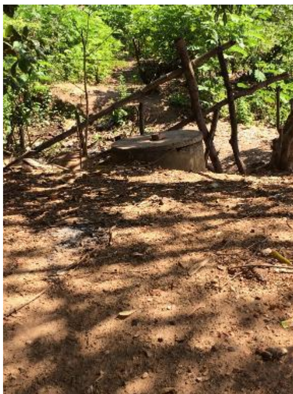
Figura 3.4 – Poço existente no paramento de jusante do dique.
