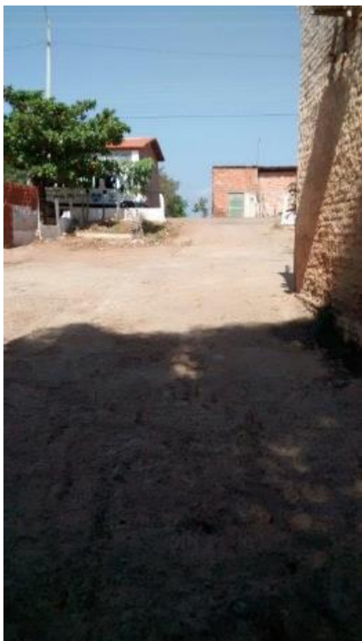
Figura 3.5a – Construção sobre o dique.
