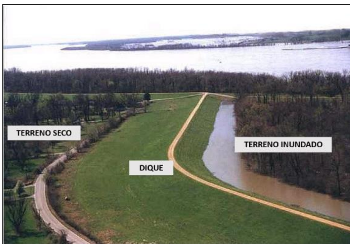
Figura 2.1 – Conceito de dique de proteção contra inundações.
