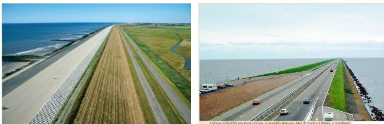
Figura 2.5 – Diques construídos em solo na Holanda.
