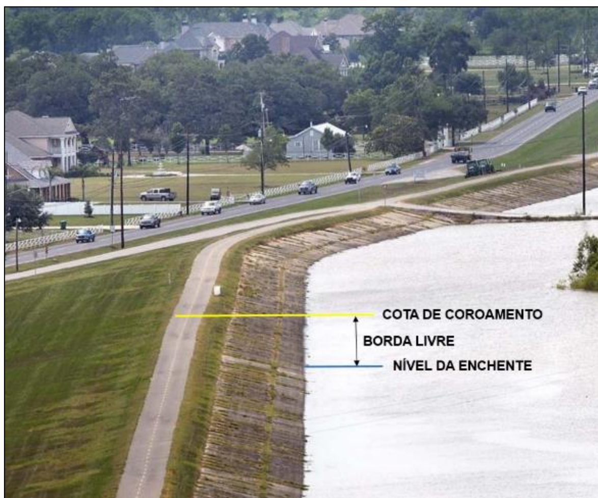
Figura 2.2 – Conceito hidráulico de dimensionamento e de segurança dos diques.
