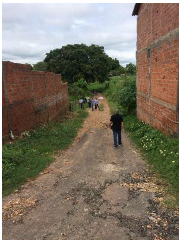
Figura 3.7 – Escavação do talude de montante para implantação de acesso.
