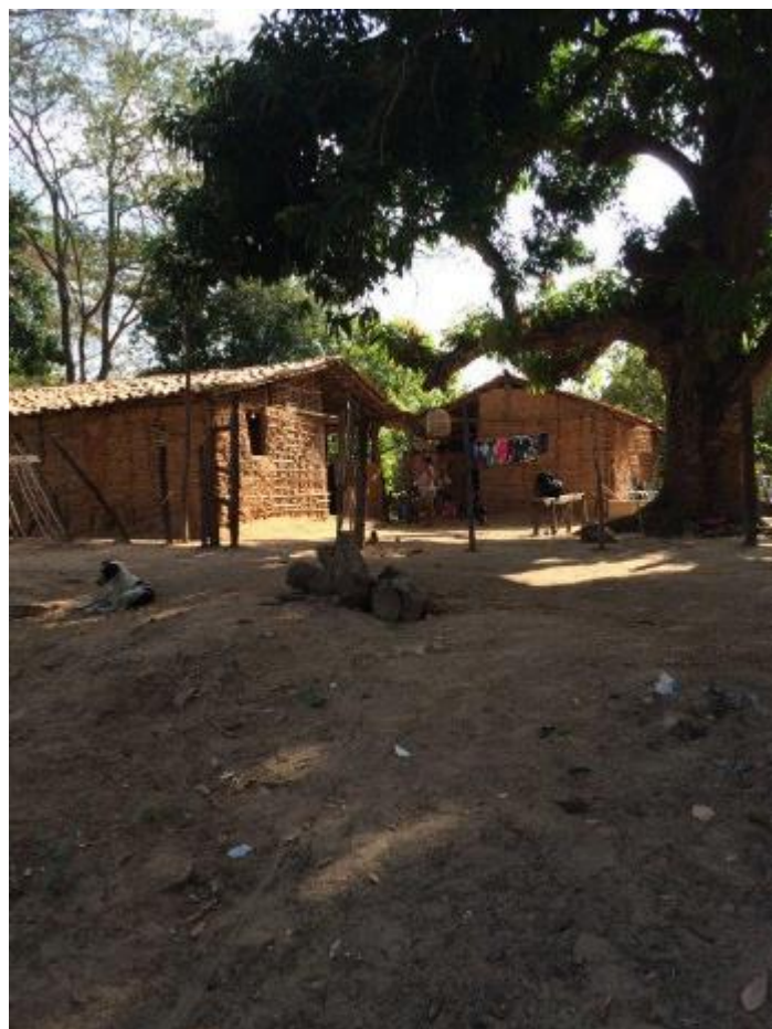
Figura 3.5b – Construção a montante do dique.
