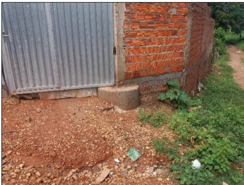
Figura 3.3 – Fundação construída no talude de montante do Dique Parnaíba.
