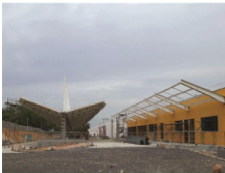
PIÇARREIRA EM EXECUÇÃO
