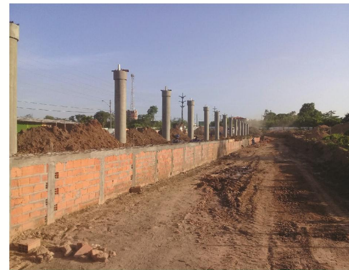
SANTA LIA EM EXECUÇÃO
