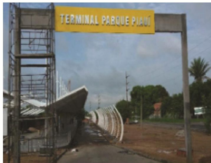
PARQUE PIAUÍ EM EXECUÇÃO
