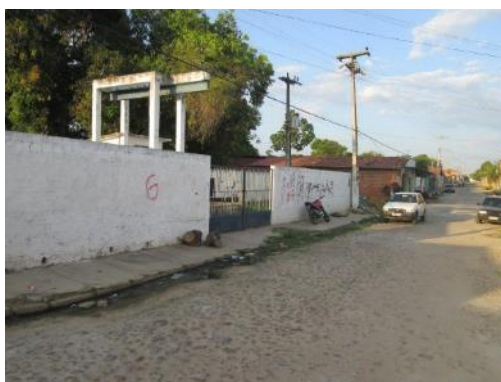
Figura 13. Vista Geral da Rua Balsas nas imediações da travessia do Canal Pe. Eduardo.
