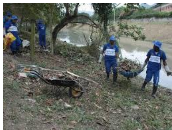
Figura 36. Exemplo de equipes realizando a limpeza manual de cursos d'água.
