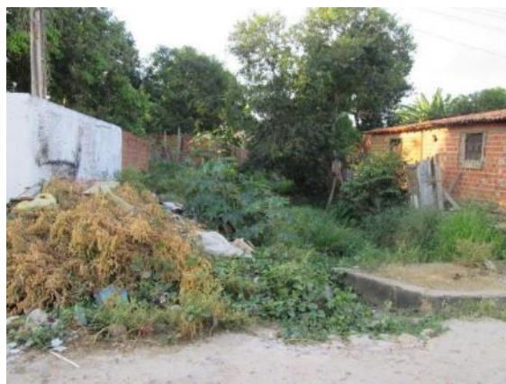
Figura 15. Rua Balsas. Outra vista do canal e edificações de entorno do Canal Pe. Eduardo.
