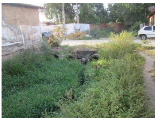
Figura 16. Vista da galeria BTTC Ø1,00m na travessia da Rua Balsas.
