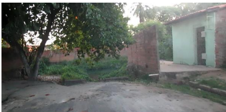
Figura 11. Final da Rua 2050 junto ao Canal Pe. Eduardo. Observa-se a existência de Galeria que passa por baixo da rua e desagua no canal.
