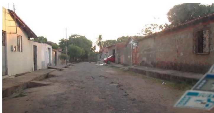
Figura 10. Vista geral da Rua – Ramal 2050, sentido Rua Tucumã - Canal.
