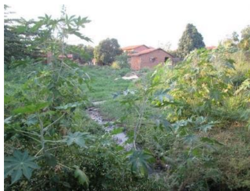
Figura 22. Vista do Canal Pe. Eduardo após a passagem por baixo das casas na Rua Antônio Pedro.
