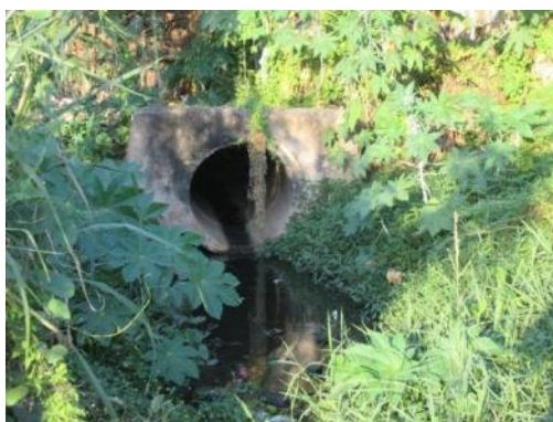
Figura 18. Vista do BSTC Ø1,00m, localizado próximo do final da rua.
