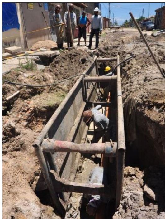
Figura 62. Exemplo que escora metálica.
