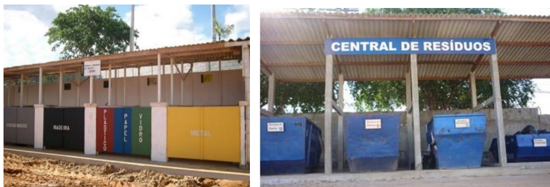
Figura 40. Acondicionamento final com baias e caçambas.
