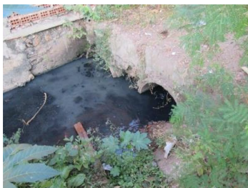
Figura 21. Vista da saída da galeria BDTC Ø1,00m no canal, que passa por baixo de casas.
