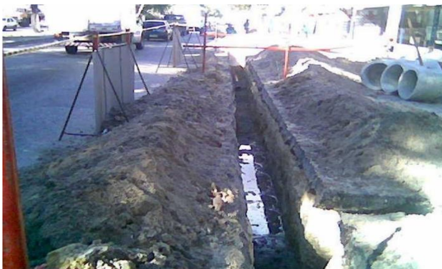
Figura 58. Exemplo de sinalização de obra para assentamento de rede de esgoto com utilização de cavaletes e fita sinalizadora.
