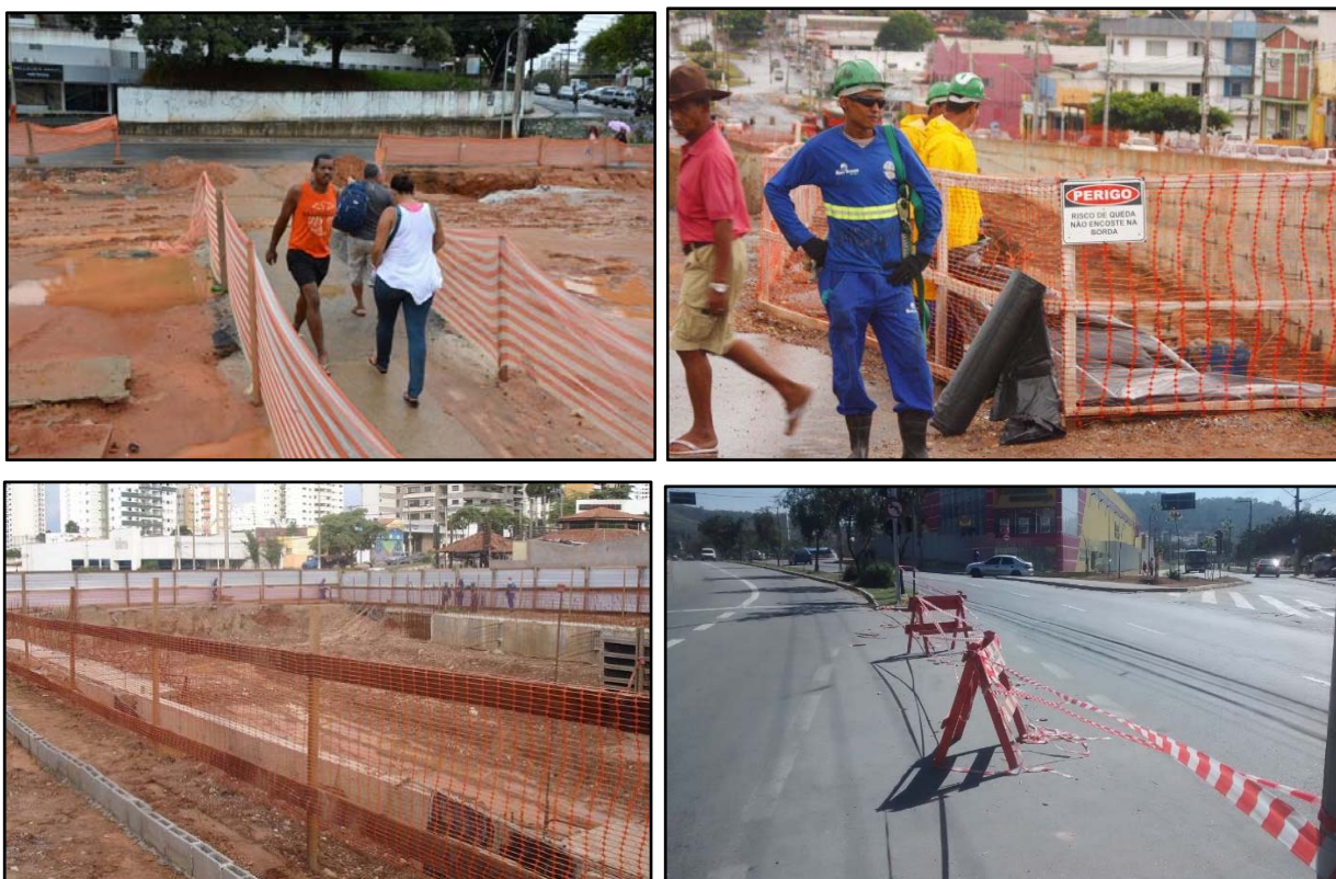
Figura 52. Exemplos de sinalização de obra com utilização de cavaletes e fita sinalizadora.
