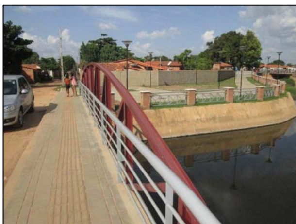
Vista do passeio e guarda-corpo lado esquerdo da ponte (sentido do estacionamento)
