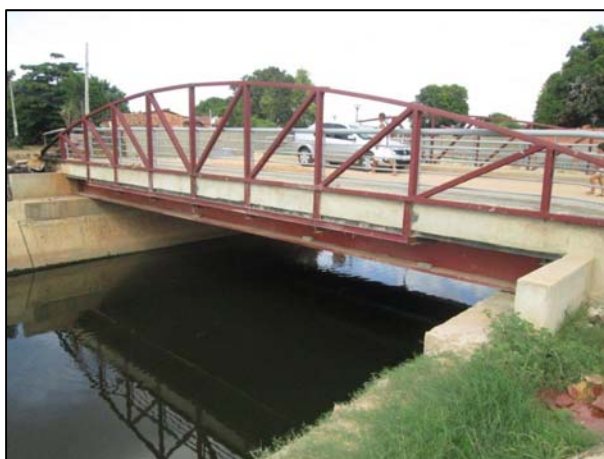
Outra vista do passeio e guarda-corpo lado direito da ponte (sentido do estaqueamento), onde será implantada a PASSARELA
