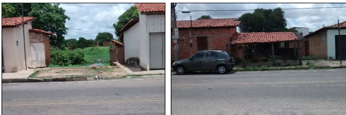
Figura 16: Vista do local da interligação existente entre a Lagoa São Joaquim e Lagoa do Jacaré (jusante e montante, da esquerda para a direita).
