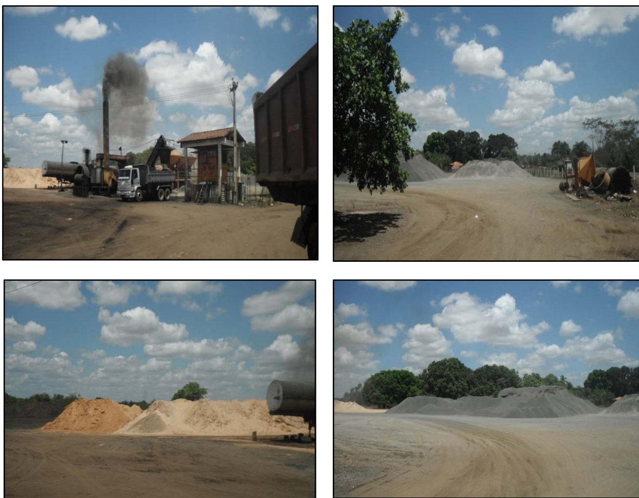
Figura 48. Usina Asfáltica – Prefeitura de Teresina.
