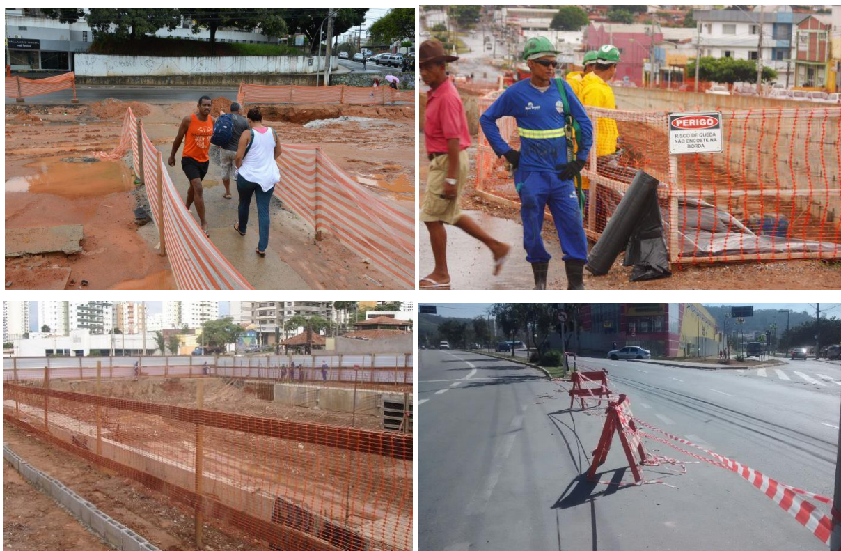
Figura 28. Exemplos de sinalização de obra com utilização de cavaletes e fita sinalizadora.
