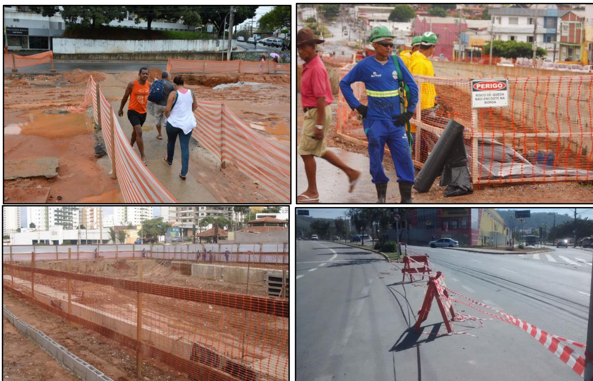
Figura 26. Exemplos de sinalização de obra com utilização de cavaletes e fita sinalizadora.
