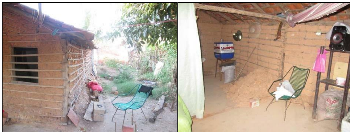
Figura 16. Exemplo de imóvel de padrão construtivo "Abaixo do Mínimo".
