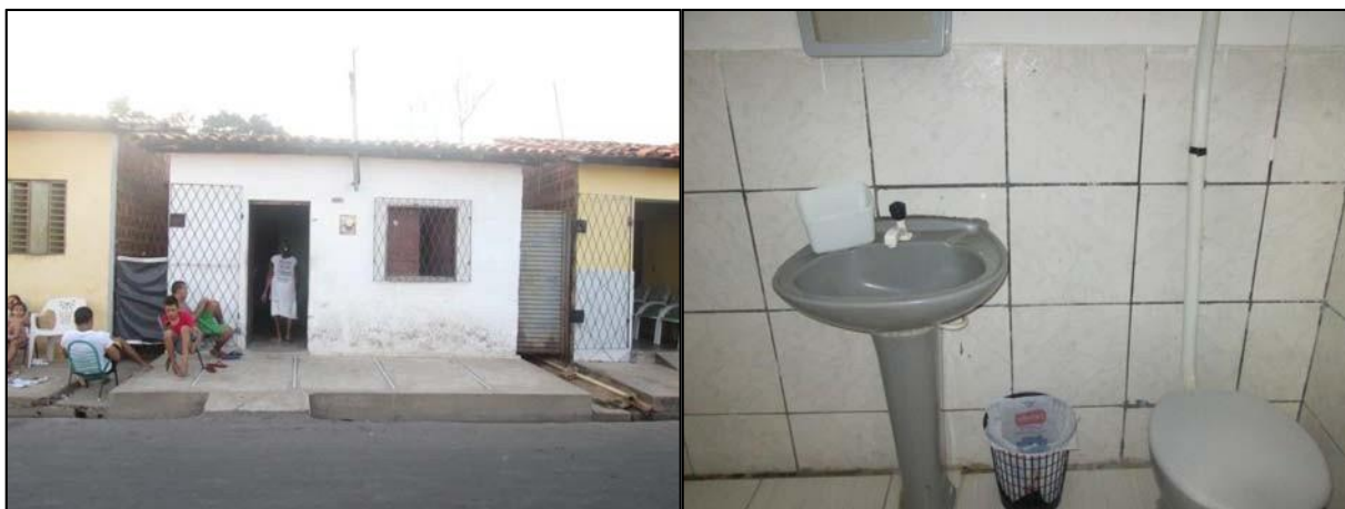
Figura 19. Exemplo de imóvel de padrão construtivo "Normal/Baixo". À esquerda, fachada. À direita, banheiro com revestimento cerâmico.
