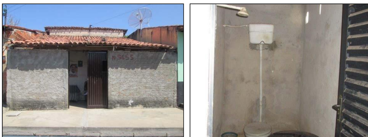
Figura 18. Exemplo de imóvel de padrão construtivo "Baixo". À esquerda, fachada. À direita, banheiro sem revestimento cerâmico.
