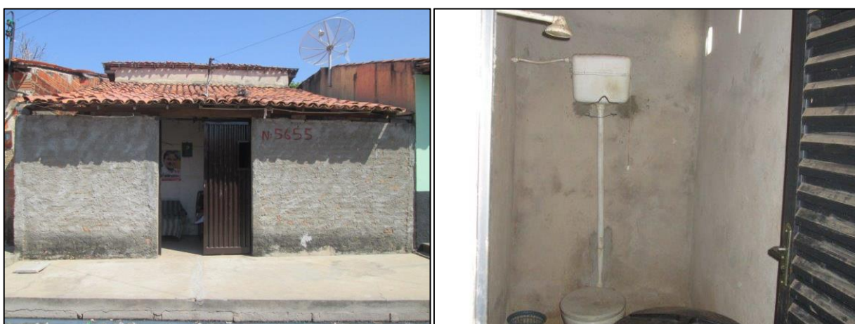
Figura 16. Exemplo de imóvel de padrão construtivo "Baixo". À esquerda, fachada. À direita, banheiro sem revestimento cerâmico.
