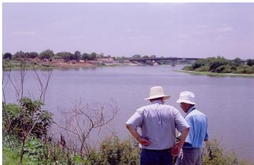
Figura 2 – Vista de montante para jusante do rio Poti, notando-se próximo à linha do horizonte a região que foi erodida na cheia de 2004, à esquerda, e a ponte Mariano Gayoso Castelo Branco, à direita.
