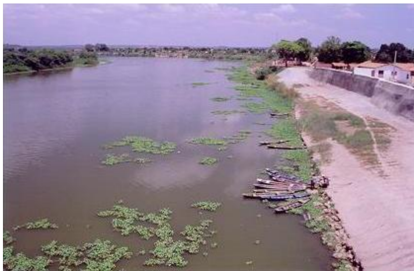
Figura 3 – Local a montante da ponte supracitada, onde ocorre um estrangulamento da calha fluvial.
