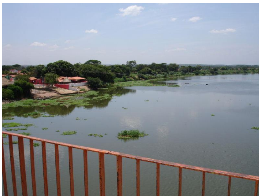
Figura 4 – Vista para jusante a partir da mesma ponte, notando-se a existência de construções na calha maior do rio Poti.
