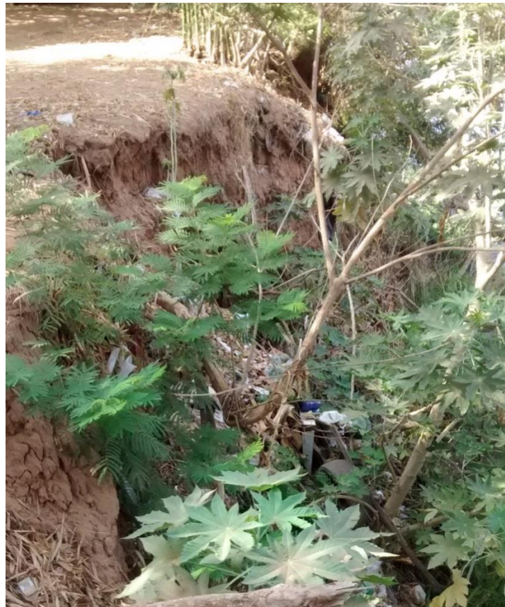
Figura 5: Rio Parnaíba — Detalhe da MD – talude íngreme/ausência da vegetação ciliar.
