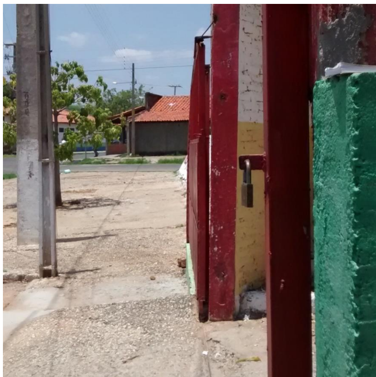
Figura 28: Dique do Poti – Portão do Restaurante / Parte do muro pintada em amarelo indica nível atingido pela cheia de 1985; a parte em branco, a borda livre.
