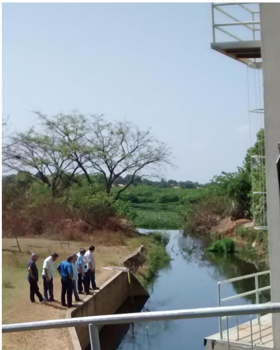
Figura 10: Elevatória dos Oleiros – Canal de adução.
