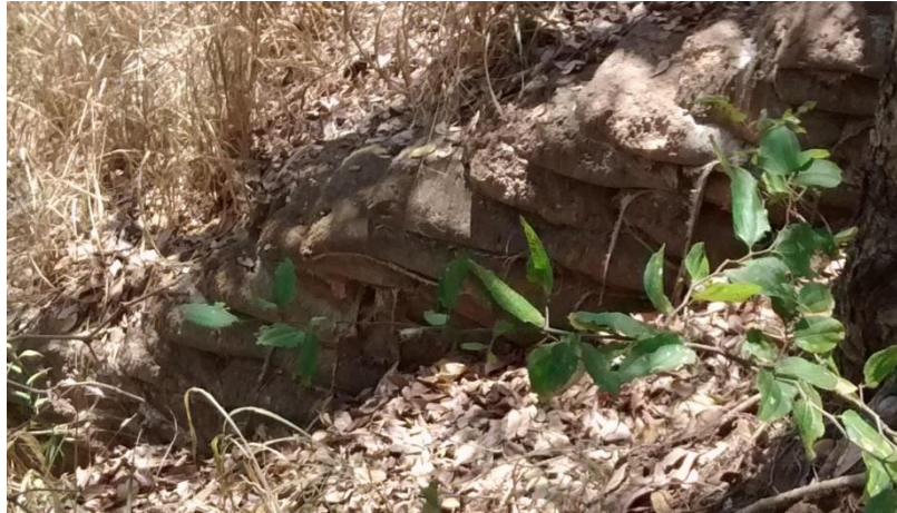
Figura 22: Dique do Poti – Proteção de talude em sacos de ráfia preenchidos com cascalho e areia (detalhe).
