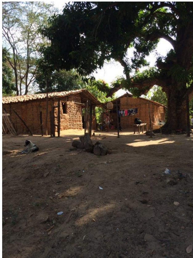
Figura 33: Dique do Parnaíba – ocupação da área de montante do dique
