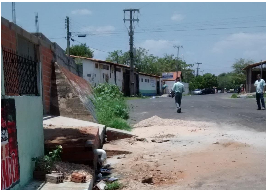
Figura 24: Dique do Poti – Muro de alteamento interrompido / Cruzamento das ruas Domingos Jorge Velho e Cedro / Acesso ao Porto e Restaurante Pesqueirinho.
