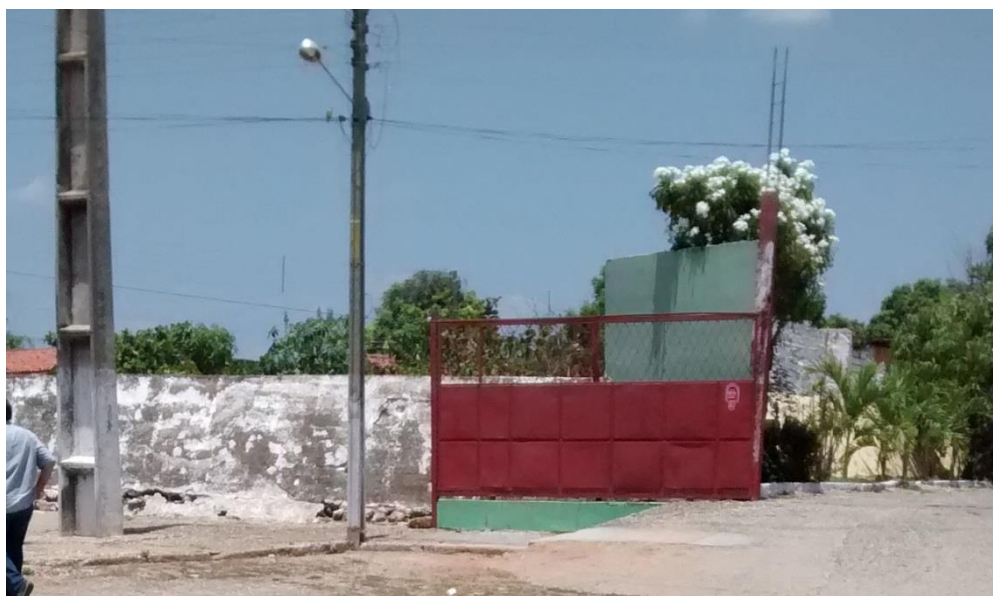
Figura 25: Dique do Poti – Muro de alteamento do dique / Portão do Restaurante / N.A. da cheia de 1985 alcançou metade da altura do portão.
