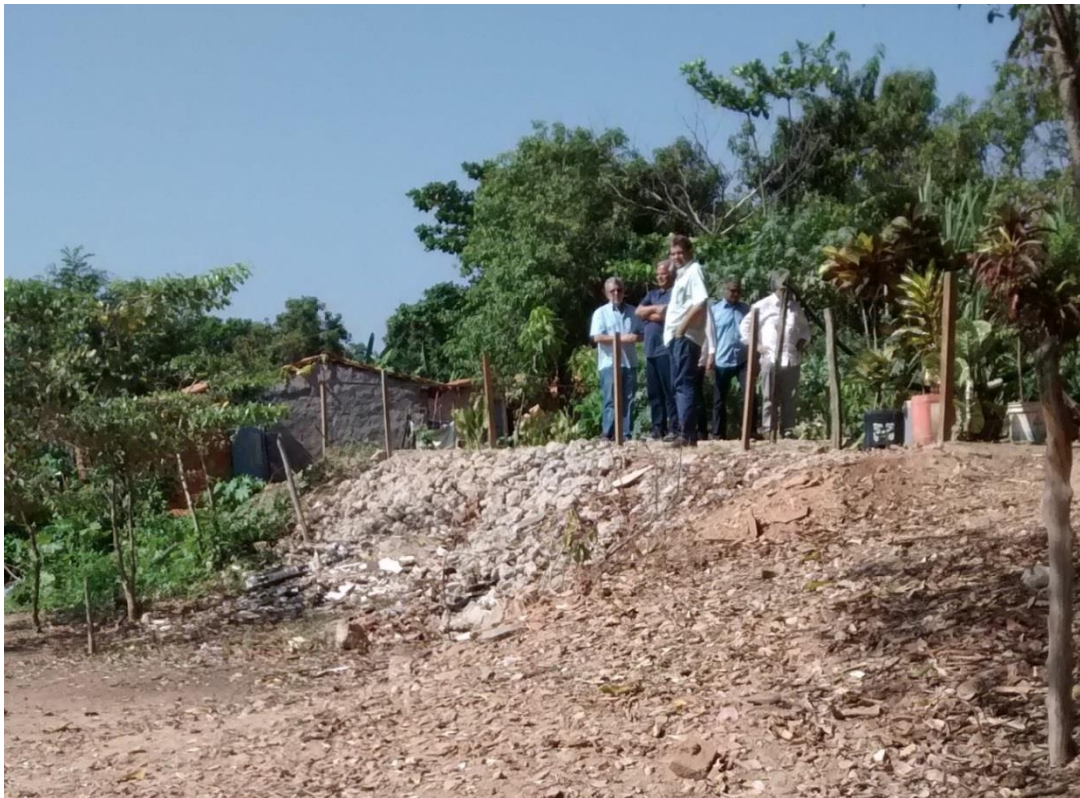
Figura 9: Lagoa dos Oleiros – Aterro e construções sobre talude do dique.
