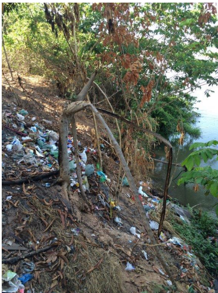
Figura 31: Dique do Parna ba – Vista do talude junto ao rio, com lixo depositado  s margens.
