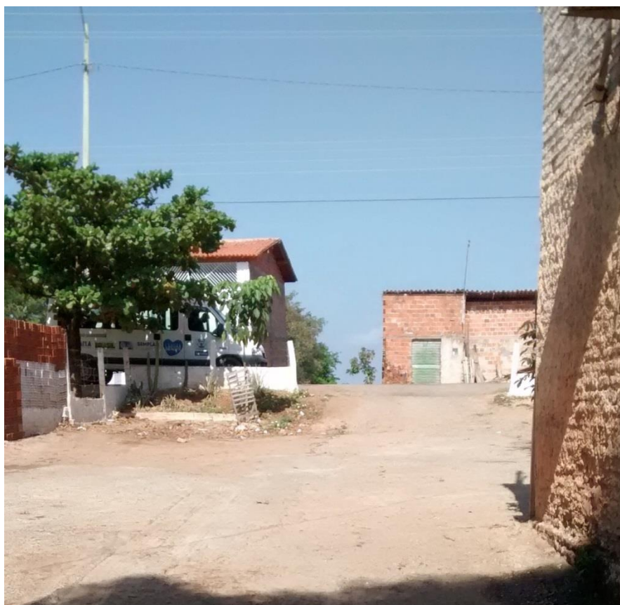
Figura 7: – Lagoa dos Oleiros –Vista para Av. Boa Esperança. Ocupação da crista e talude interno do dique
