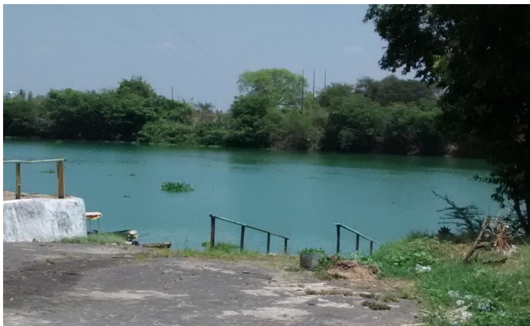
Figura 26: Dique do Poti – Porto do Pesqueirinho / Margem direita protegida por vegetação (ao fundo).
