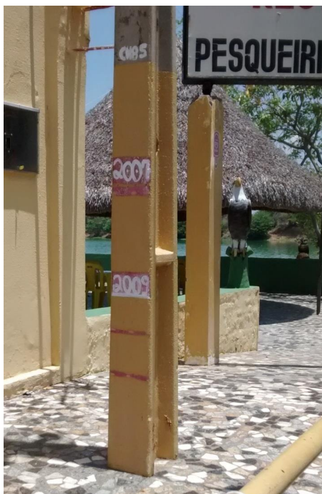
Figura 27: Dique do Poti – Marcas das cheias de 1985, 2007 e 2009 junto ao Restaurante.
