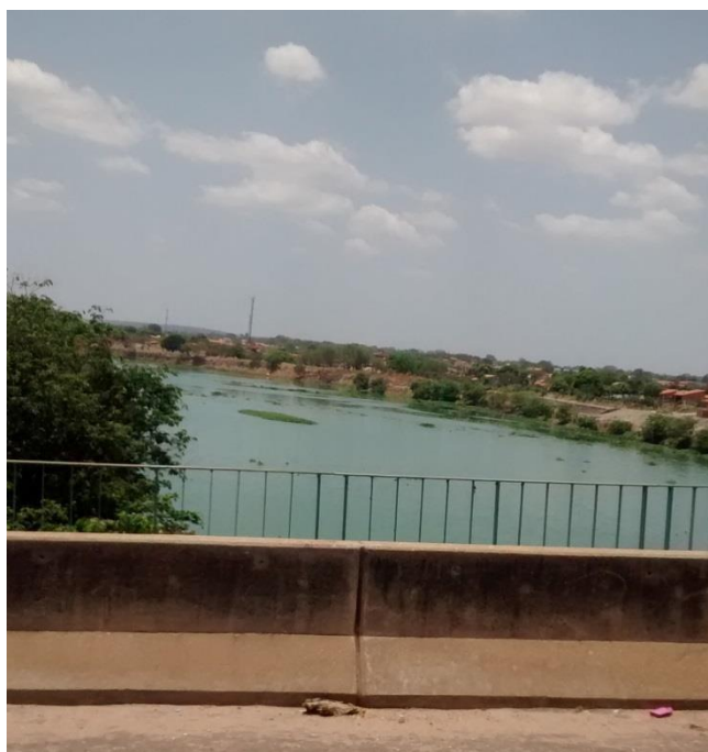
Figura 29: Dique do Poti –Montante da ponte Mariano Gayoso Castelo Branco / Trecho de talude protegido com gabiões / Construções sobre crista do dique e entre esta e a margem do rio
