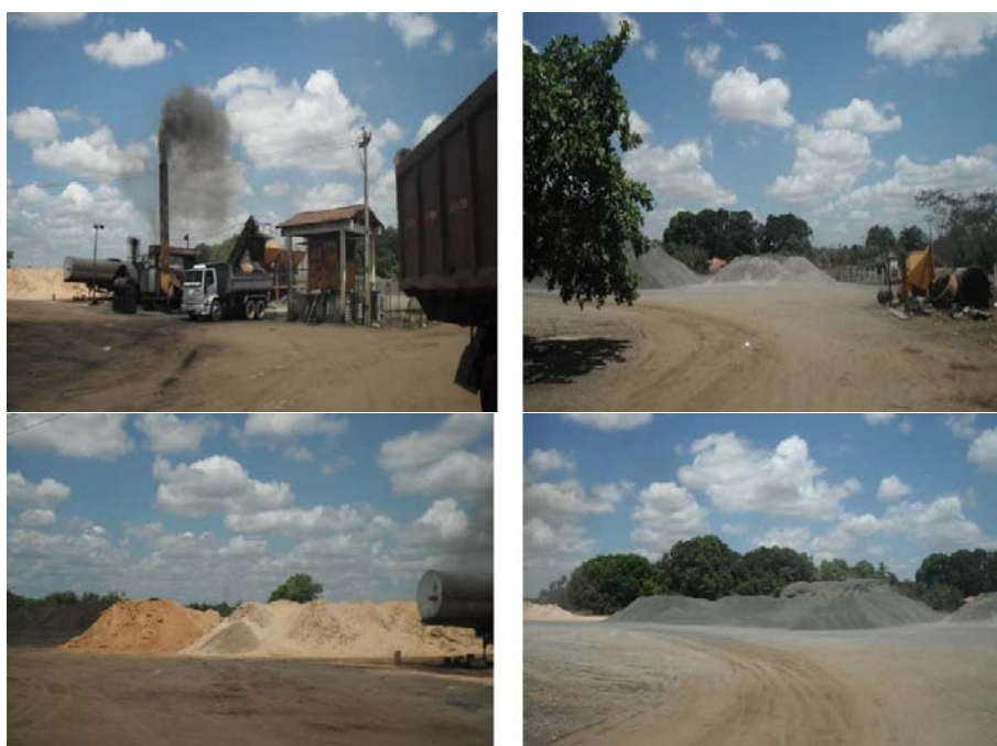
Figura 14. Imagens da usina de asfalto pertencente à Prefeitura de Teresina.
