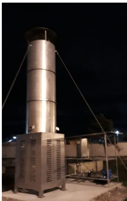
Figura 23 - Modelo de flare enclausurado para queima de biogás
