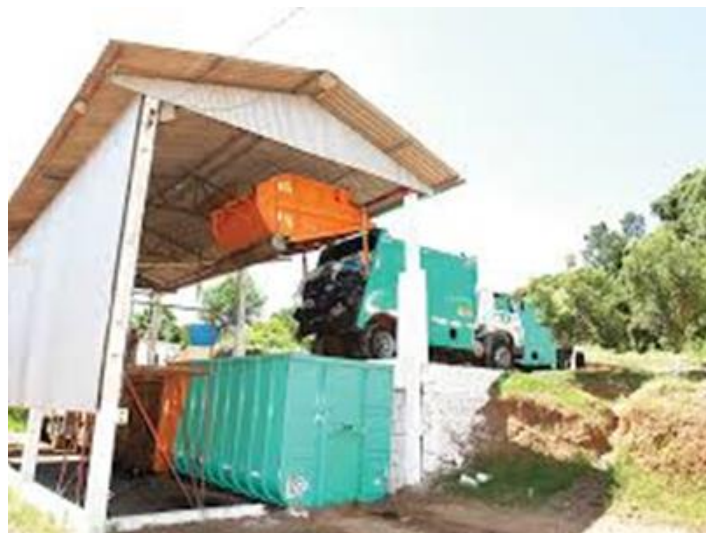
Figura 26 – Plataforma de ET com cobertura.
