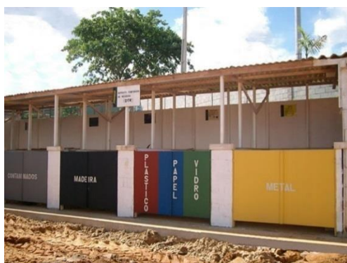
Figura 35. Acondicionamento final com baias e caçambas.
