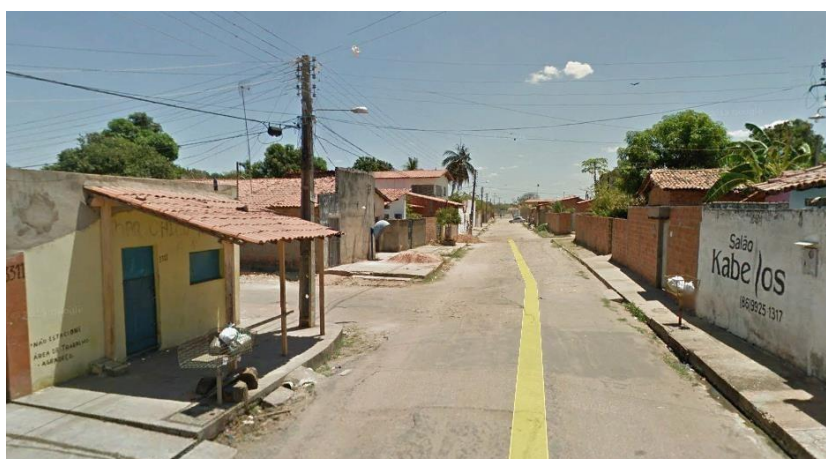
Figura 19. Vista Geral da Rua Tucumã, na interseção com o Ramo 2050.
