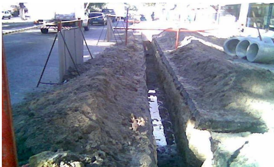
Figura 52. Exemplo de sinalização de obra para assentamento de rede de esgoto com utilização de cavaletes e fita sinalizadora.
