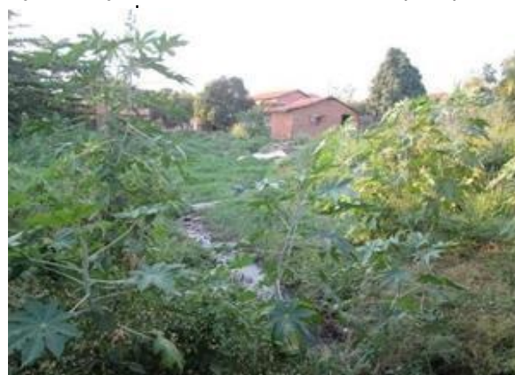
Figura 18. Vista do Canal Pe. Eduardo após a passagem por baixo das casas na Rua Antônio Pedro.
