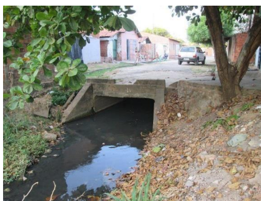
Figura 12. Vista Geral da Rua Ramal 2050, sentido Canal – Rua Tucumã. Galeria BSCC 2,50m x 1,50m, cuja estrutura será prolongada para permitir a continuação da rua em direção à Rua Balsas.
