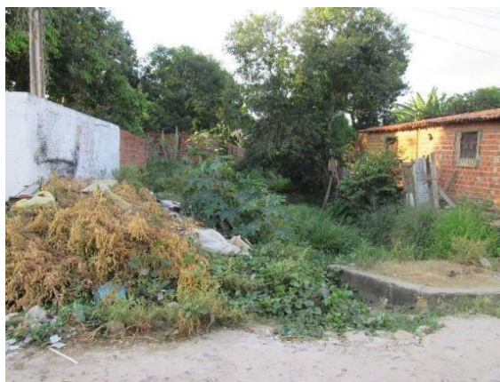
Figura 13. Rua Balsas. Outra vista do canal e edificações de entorno do Canal Pe. Eduardo.
