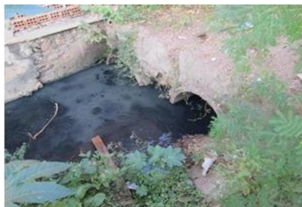
Figura 17. Vista da saída da galeria BDTC Ø1,00m no canal, que passa por baixo de casas.
