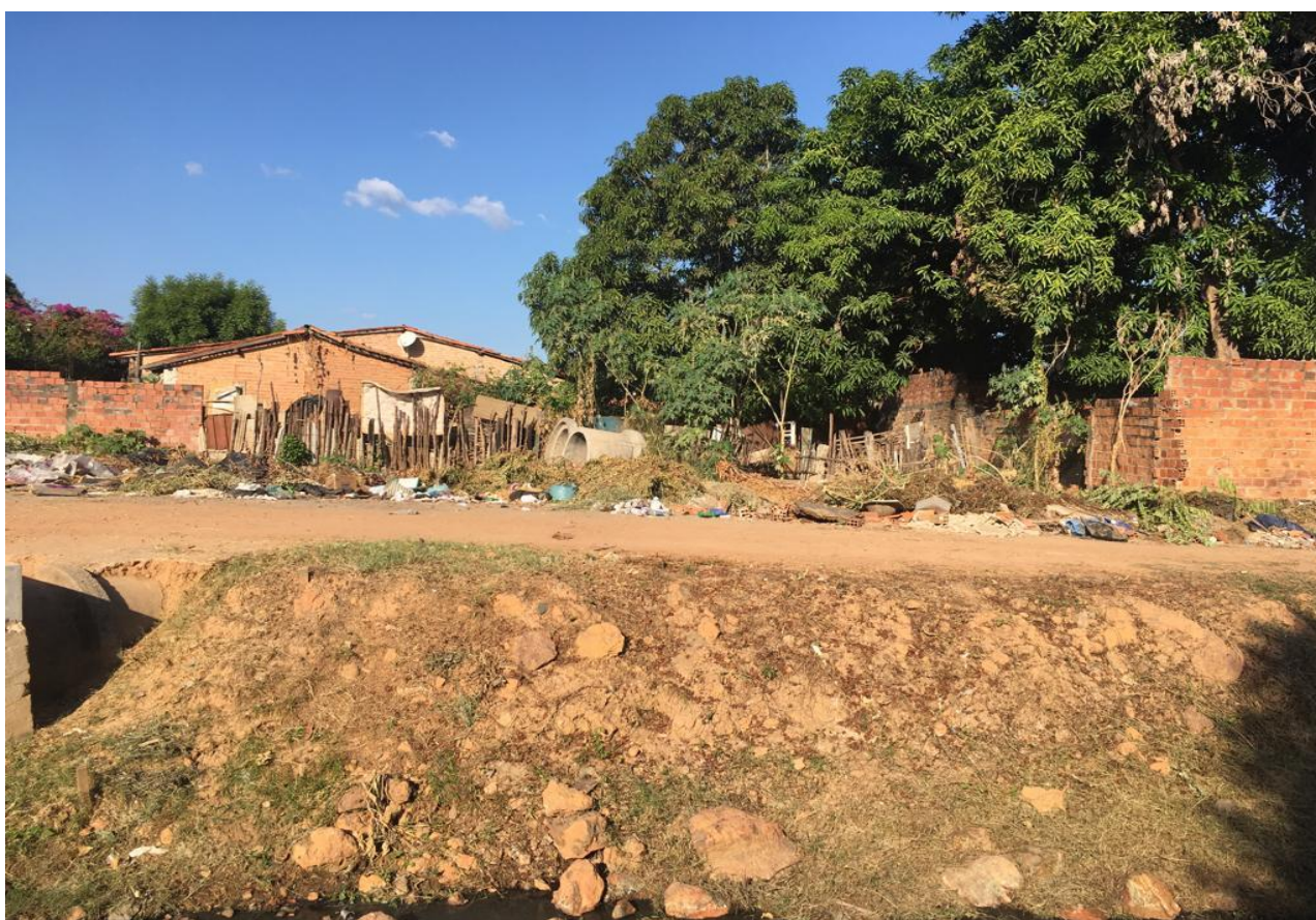
Foto 3: Área prevista para implantação do canteiro de obras.
