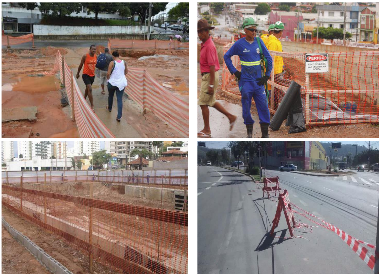
Figura 8: Exemplos de sinalização de obra com utilização de cavaletes, fita sinalizadora e redes de proteção.
