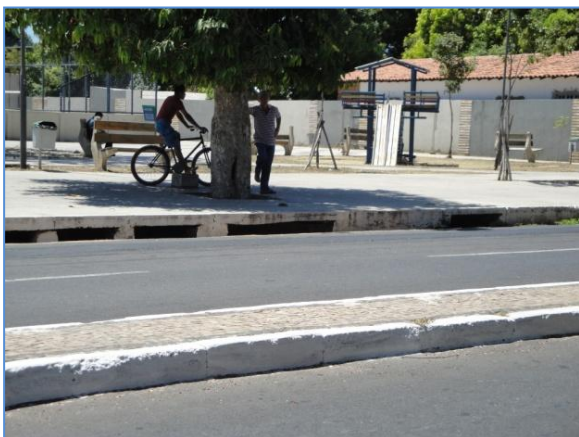
c) Na Avenida Centenário, bairro Aeroporto, as bocas de lobo em excesso indicam quantidade de água pluvial também em excesso. Sub-bacia maior do Programa Lagoas do Norte.
