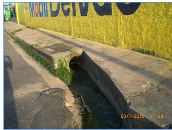
d) Rua Major Sebastião Saraiva mostrando típica "passagem molhada", dispositivo muito comum na periferia que também comumente escoar esgoto.
