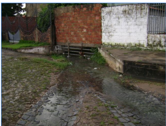
e) Vista parcial da rede pluvial no Bairro Porenquanto, Zona Norte. Sub-bacia PE 16.
