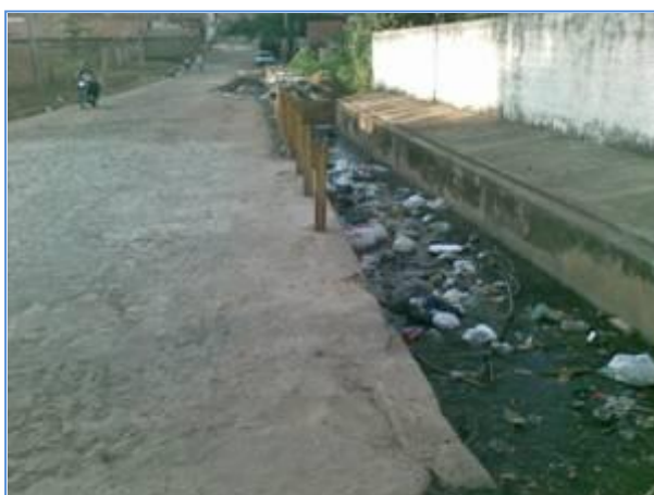
a) Canal aberto cheio de lixo na rua em frente à Quadra “N” do Conjunto Redenção - Zona Sul.
