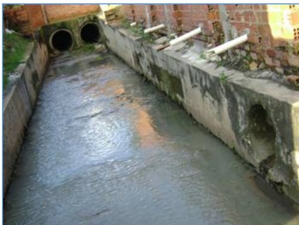
a) Vista de canal pluvial em bairro da Zona Sudeste e os tubos de esgoto sanitário. Sub-bacia PD 06.
