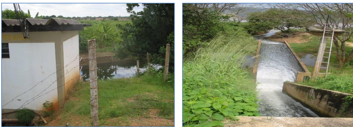
Figura 2.212. Casa de bombas e bombeamento da lagoa dos Oleiros para o rio Parnaíba, na sub-bacia LDN.
