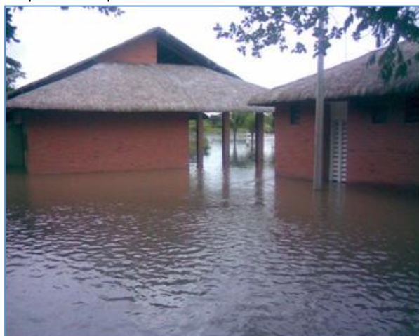
c) Visão parcial de quiosques do Balneário Curva São Paulo sob influência da cheia do rio Poti, Zona Sudeste. Sub-bacia PD 01.
