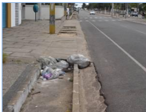
b) Na Av. Kennedy, resíduos sólidos obstruem dispositivo de drenagem pluvial.
