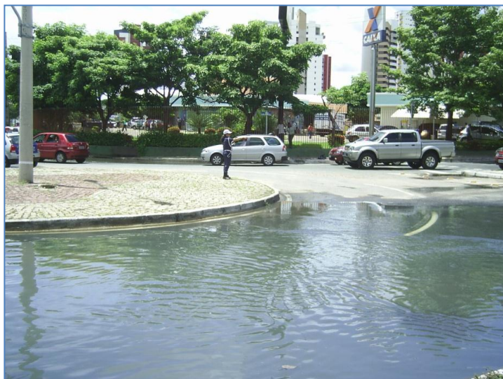
Figura 9.14. Alagamento na rotatória da Av. Raul Lopes com a Av. Jôquei Clube.
