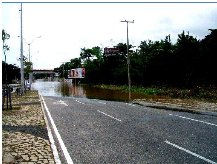
Figura 9.15. Alagamento na Av. Raul Lopes.
