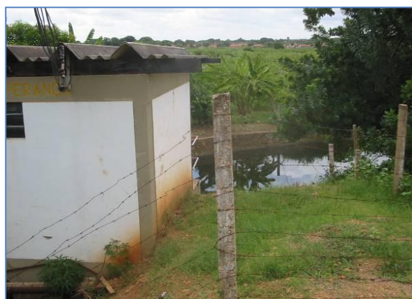
b) Casa de bombas da Lagoa dos Oleiros.
