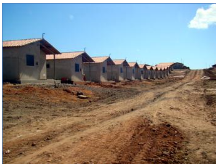
Figura 9.20. Visão parcial do Nova Alegria em construção: junho/2009 (Fonte: www.pi.gov.br/materia.php?id=35618 ).
