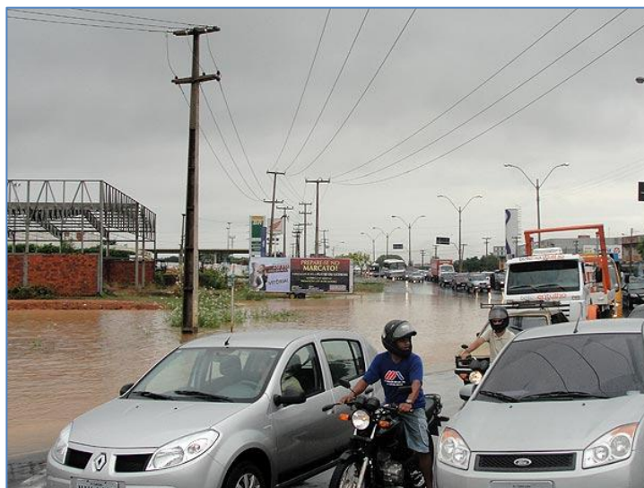
Figura 9.31. Acúmulo de águas pluviais e consequente engarrafamento do tráfego, promovido pela falta de dispositivos de drenagem pluvial no Balão da Av. Miguel Rosa.
