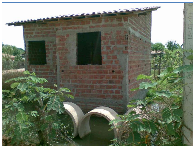
Figura 9.2. Casa em construção dentro de área alagadiça do bairro Recanto dos Pássaros.
