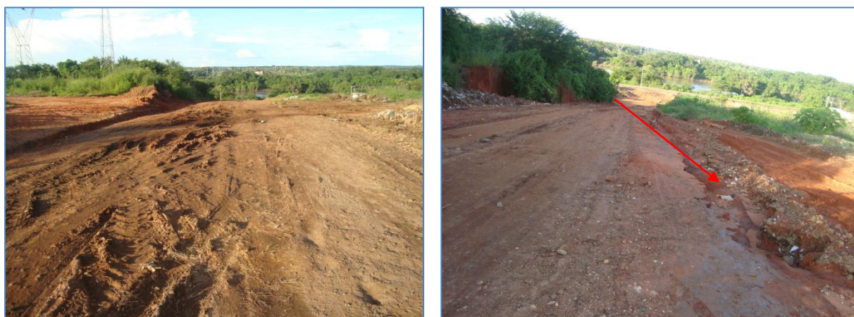
Figura 10.7. Avenida principal do Loteamento Hugo Prado: sem pavimento e drenagem o solo exposto é levado pelo escoamento superficial, provocando a abertura de sulcos.
