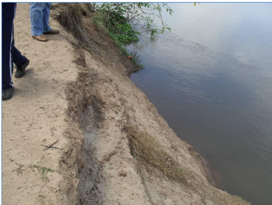
Figura 10.9. Detalhe da margem côncava de um meandro do rio Poti, onde ocorre processo erosivo.
