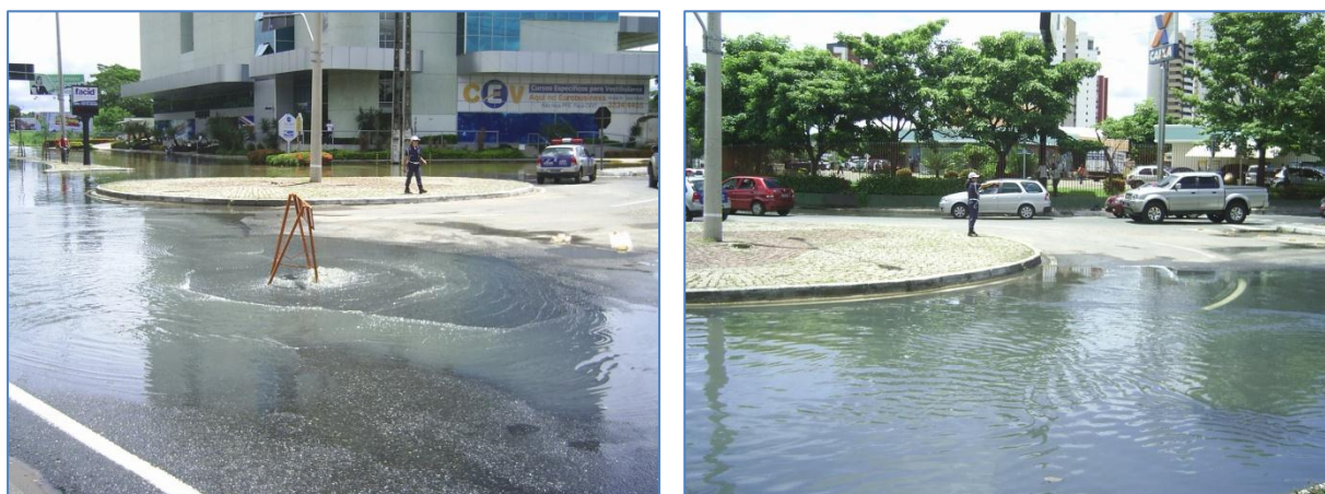
Figura 10.13. Refluxo de água da drenagem pluvial, inundando as regiões mais baixas: Rua Raul Lopes em frente ao Eurobusiness.
