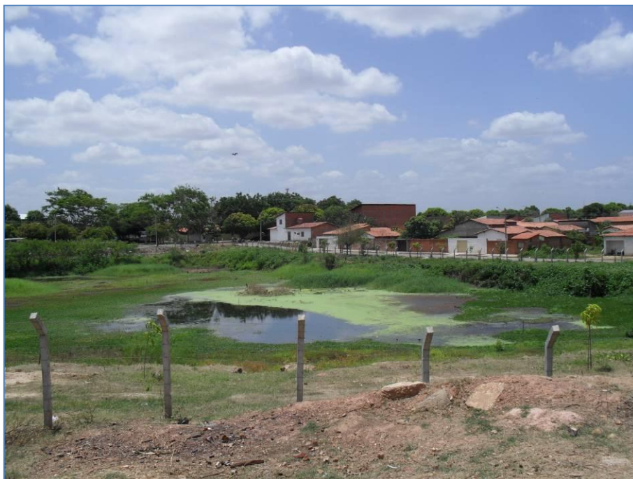
Figura 10.14. Lagoa que durante os períodos de chuva tem seu volume d’água aumentado, esse fato somado a ausência de drenagens faz com que a mesma transborde, alagando regiões de topografias mais baixas a sua volta.
