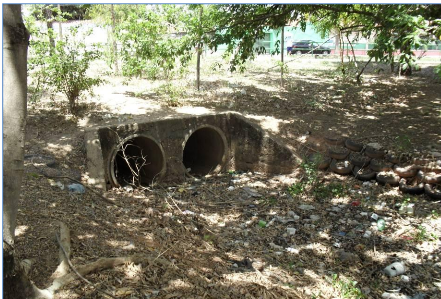
Figura 12.2. Canal de interligação entre as lagoas.
