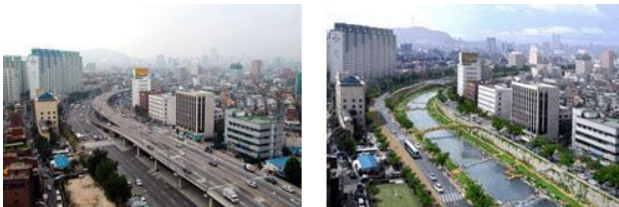
Figura 15.1. Situação prévia e perspectiva da restauração do rio Cheonggyecheon (Seul, Coréia do Sul). 1
