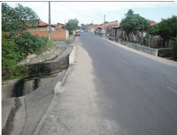
Pontilhão Rua Zaul Pedreira – ponto P100
