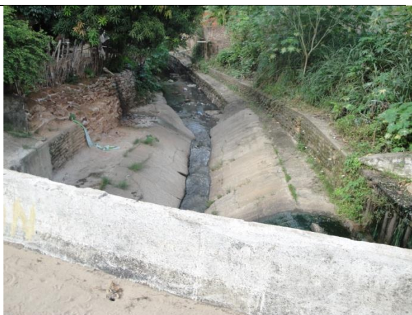
Pontilhão Rua Zaul Pedreira – visando P101
