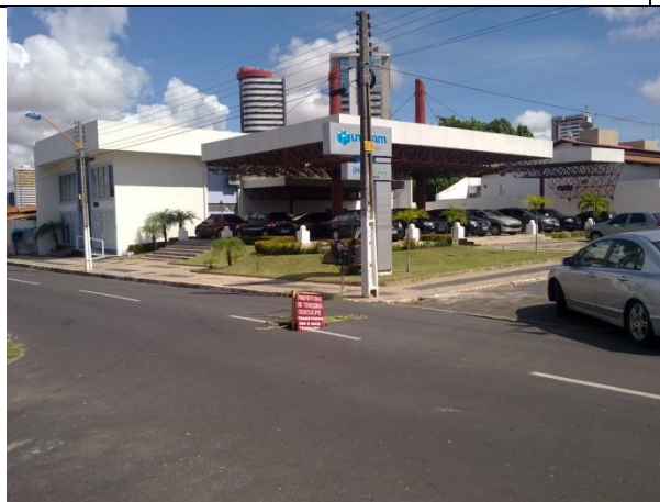
P17 avariado, porém sem condições de acesso
