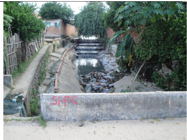
Pontilhão Rua Zaul Pedreira – visando P99
